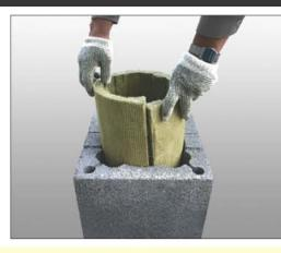
4.3 Sulenkta vatą statome į modulinį blokelį. Vatos sujungimą reikia statyt taip, kad jis neatsidurtų ties vėdinimo kanalu.
